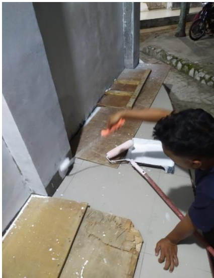
Gambar 5. Pengecatan Dinding Dengan Kuas Roll
