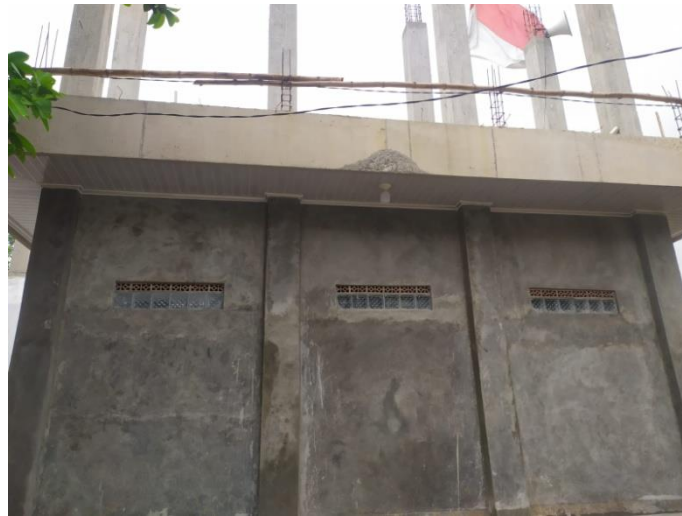
Gambar 1 Visual Dinding Sebelum Pengecatan
