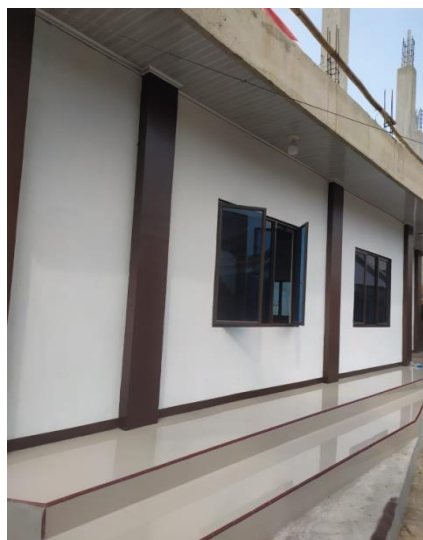
Gambar 8 Hasil Akhir Setelah Pengecatan Dinding Kanan Masjid
