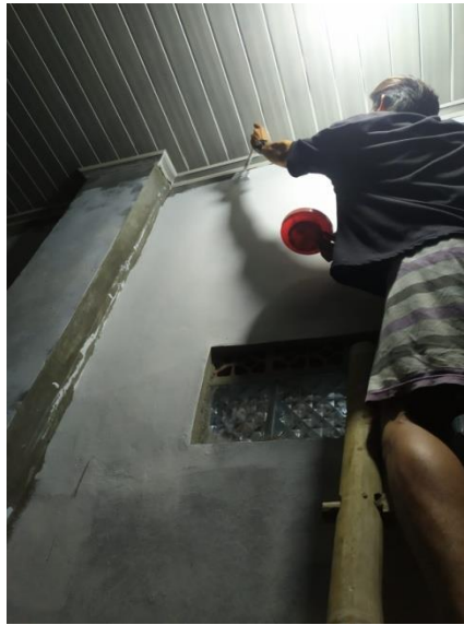
Gambar 4 Pengecatan Dinding Dengan Bantuan Tangga
