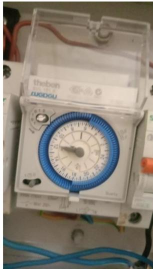
Gambar 1.5. Pemasangan Relai Waktu Panel Penerangan
