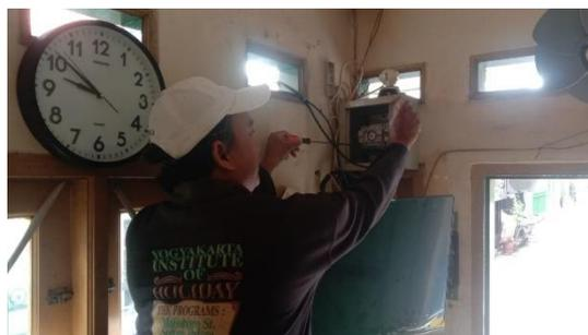
Gambar 1.6. Pemasangan Panel Penerangan
