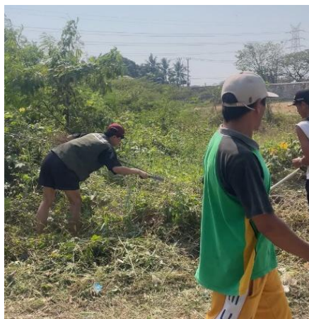
Gambar 5. Pemotongan rumput di area pembangunan rocket stove
