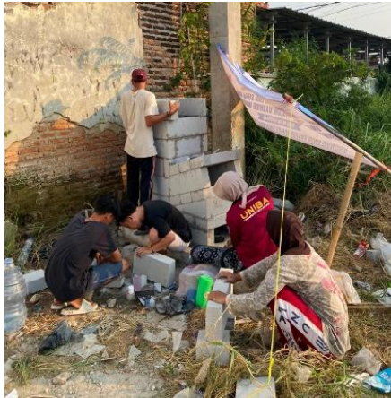
Gambar 6. Pembangunan rocket stove
