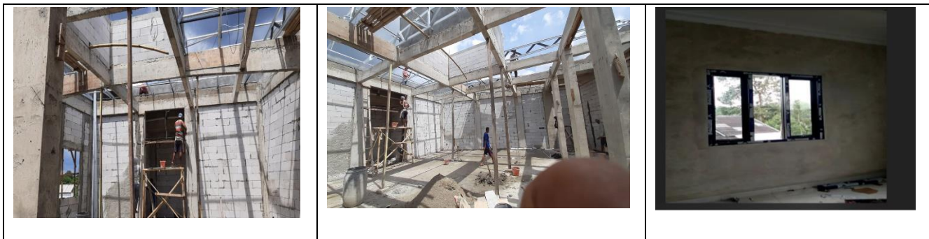
Gambar 13. Prses Pekerjaan finishing
