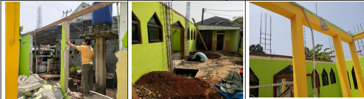
Gambar 8. Prses pembongkaran bangunan
