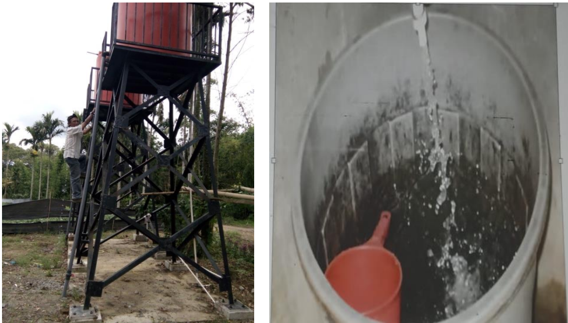
Gambar 1. Survei Tangki Penampungan Air Sumur Bor Masyarakat
