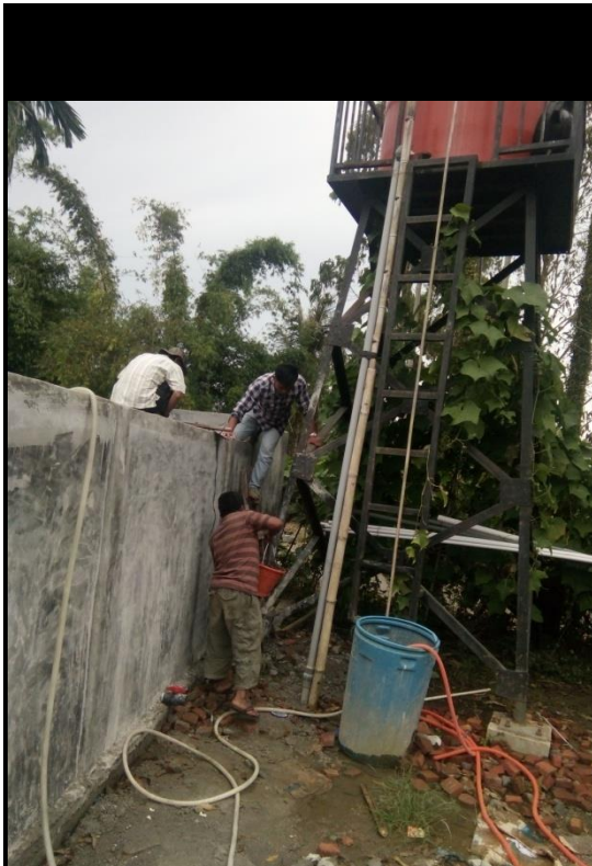
Gambar 3. Pengisian karbon aktif pada bak pengolahan air
