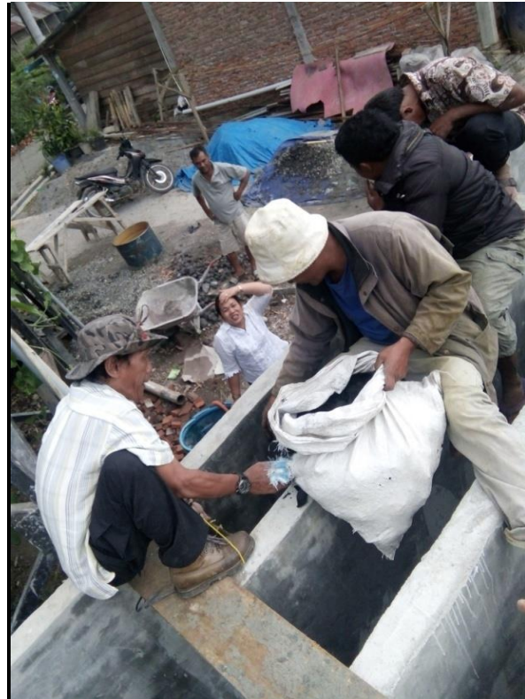
Gambar 3. Pengisian karbon aktif pada bak pengolahan air
