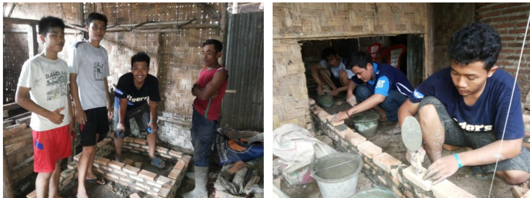
Gambar 3 Pembangunan Digester Biogas Kotoran Sapi
